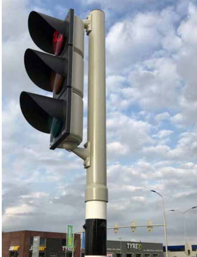
verkeerslantaarn aan-mast-montage middels opzetstuk
