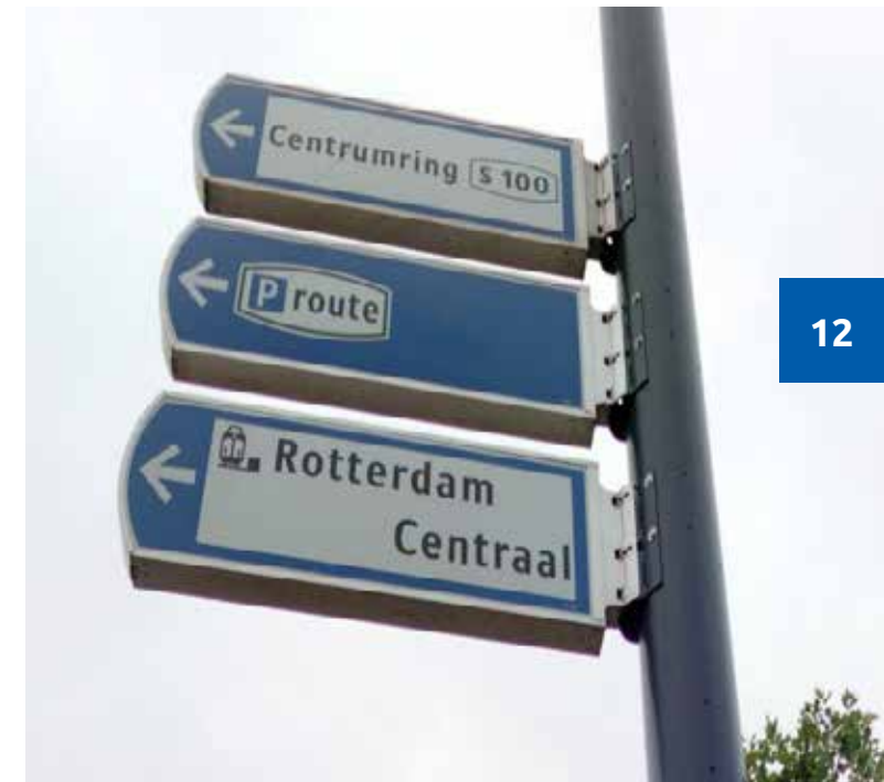
lichtwegwijzer gemonteerd op een grote buisdiameter
