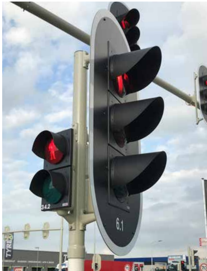
opzetstuk met verschillende formaten van verkeerslantaarns
