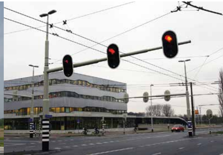
uithoudercombinatie met bovenleiding en openbare verlichting
