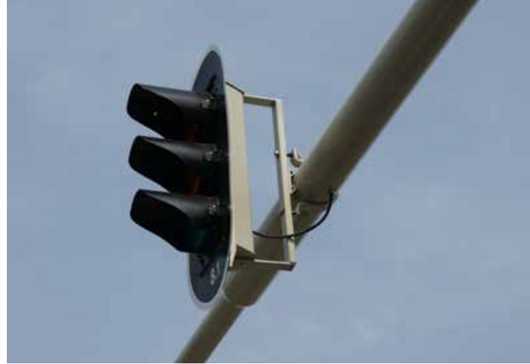
windvormfactor van een verkeerslantaarn met achtergrondschild: 1,32
