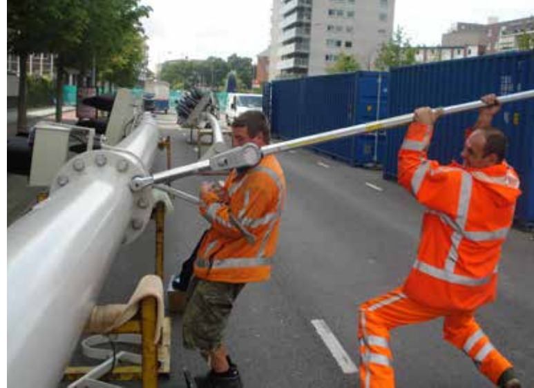
bevestigingsmaterialen aandraaien met een momentsleutel
