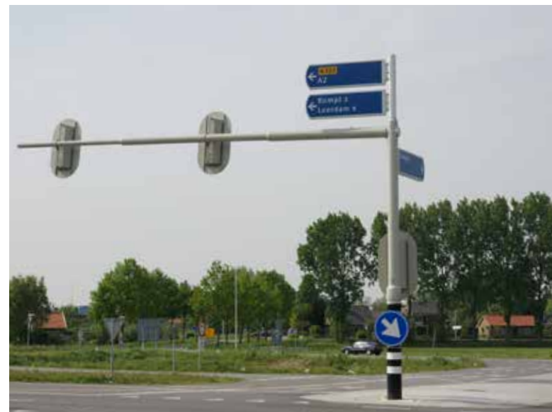
uithoudercombinatie gecombineerd met bewegwijzering
